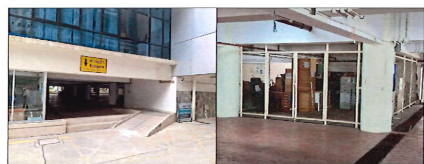
รูปถ่ายพื้นที่รื้อถอน
