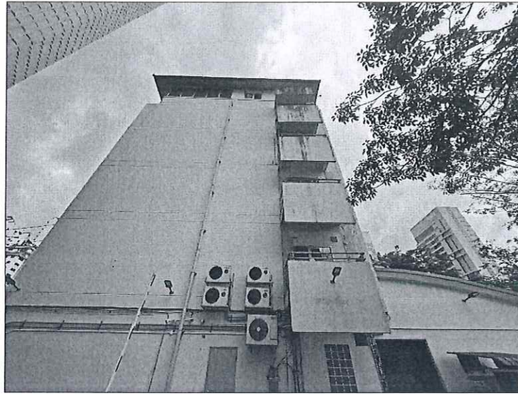
งานซ่อมแซมและทาสีผนังภายนอกอาคาร
