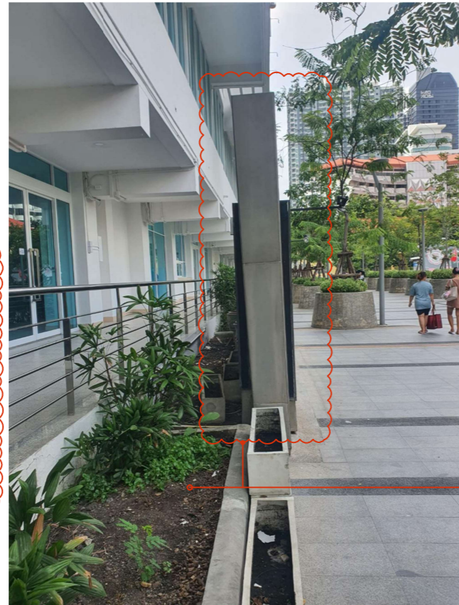
รื้อถอนป้ายเดิม โคมไฟ พร้อมสายและสวิทช์ จำนวน 2 ชุด รื้อถอนขนย้ายต้นไม้ กระบะเดิม พร้อมทำความสะอาด
